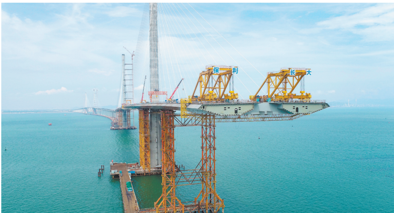
黄茅海大桥钢箱梁吊装进度已超8成。图为钢箱梁吊装施工现场。
