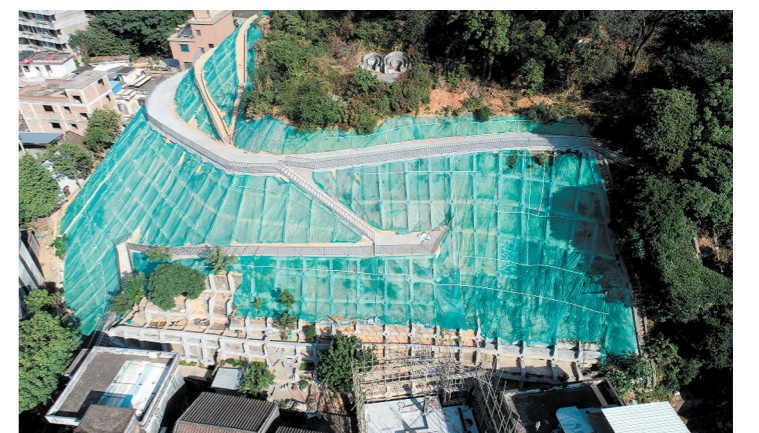
象山地质灾害点整治后的坡面。
