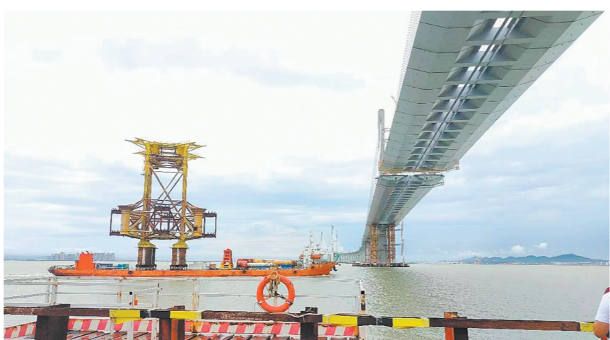
“瀚航1”轮安全通过在建的黄茅海大桥。
