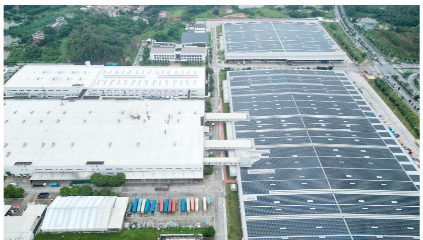
一排排光伏板在厂房屋顶整齐铺开,用绿色能源替代传统能源,助力节能降碳。
