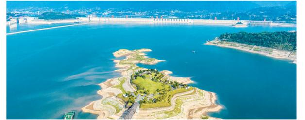
6月6日在湖北省宜昌市秭归县拍摄的水位下降后的三峡大坝，三峡水库水位下降后的消落带清晰可见（无人机照片）。当日8时，三峡水库水位消落至145米，提前4天完成消落任务。这意味着三峡水库已腾出221.5亿立方米防洪库容，正式转入汛期防洪调度。
