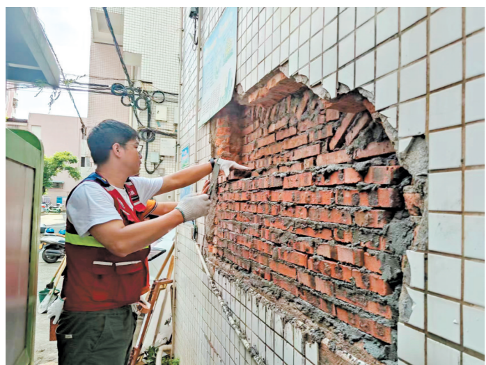
党员志愿者、网格员修补小区“破洞墙”。
