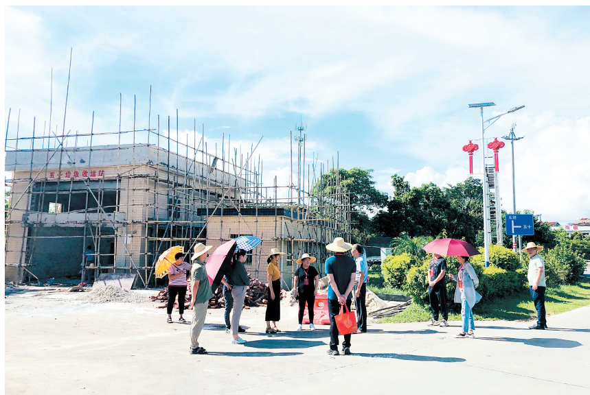
人大代表深入一线，调研垃圾收运站建设情况。
