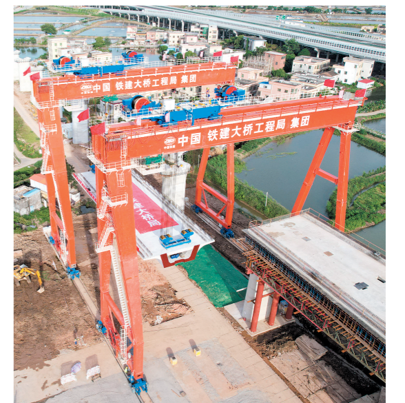
昨日,深江铁路进行首榀箱梁架设。
