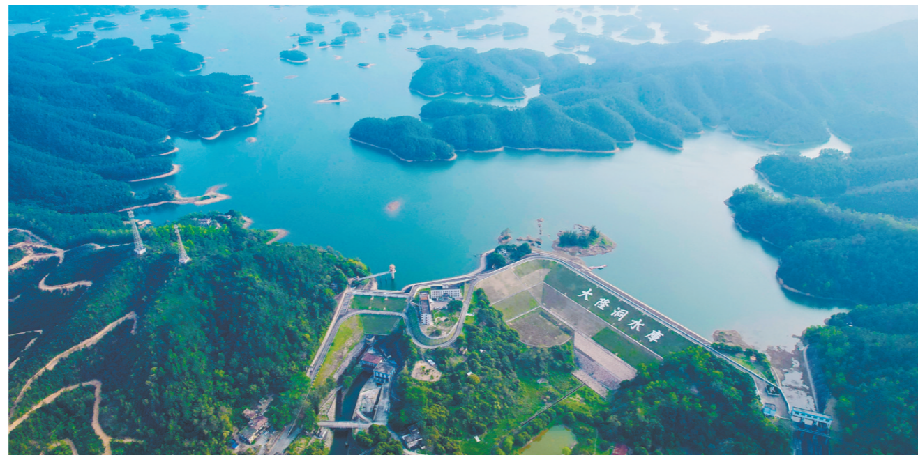
2023年,我市启动实施水库除险加固项目。图为改造后的台山大同洞水库。
