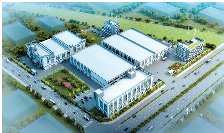
中顺智能装备产业园将有效助力恩平智能装备制造产业延链补链强链。图为产业园效果图。恩平工业园供图
