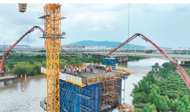
施工人员对深江铁路跨江门水道连续梁0号块进行浇筑。
