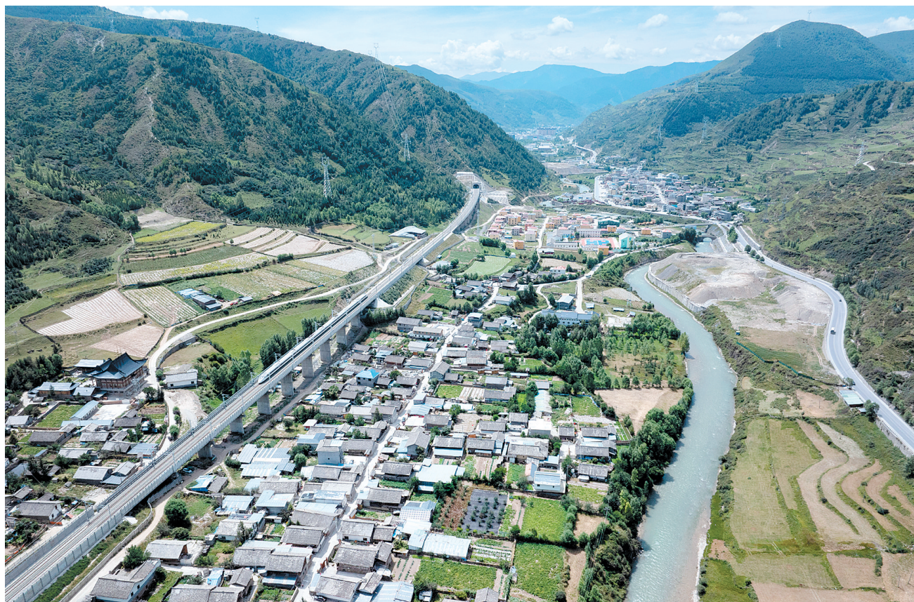
8月30日,C5764次列车行经在川青铁路黄龙九寨站至松潘站间,铁路边是岷江和213国道(无人机照片)。新华社发
