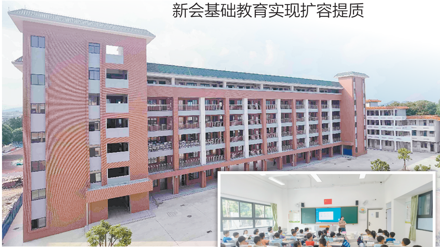
▲新会一中附属凤山湖中学改扩建工程项目有新进展,新建教学综合楼成为校园内的一道风景线。
