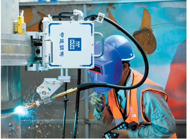
9月5日，10台智能焊接机器人在深圳湾超级总部基地C塔项目建设现场正式投入使用。本次投用的柔性焊接机器人由中建科工自主研发，承担项目东塔10根直径2.5米外框钢柱、约7000吨钢构件的现场焊接任务。
