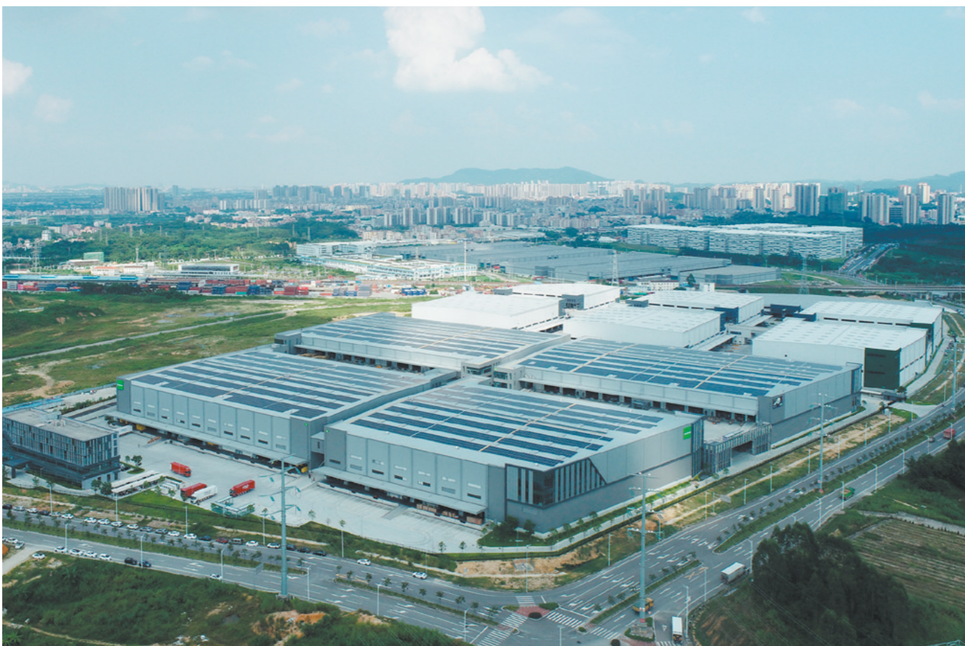
珠西国际陆港一期项目。
