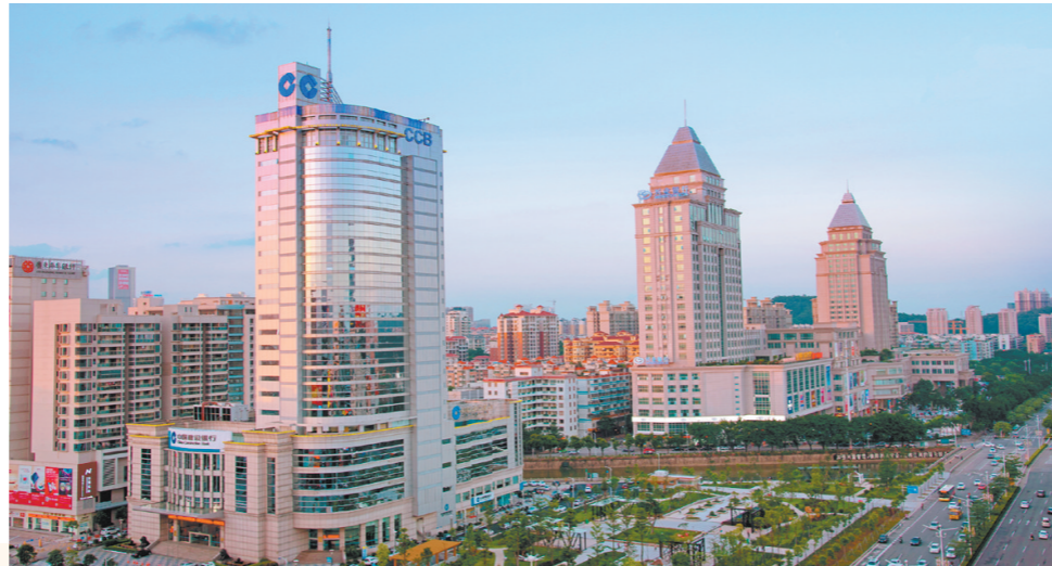
建设银行江门市分行办公大楼。
