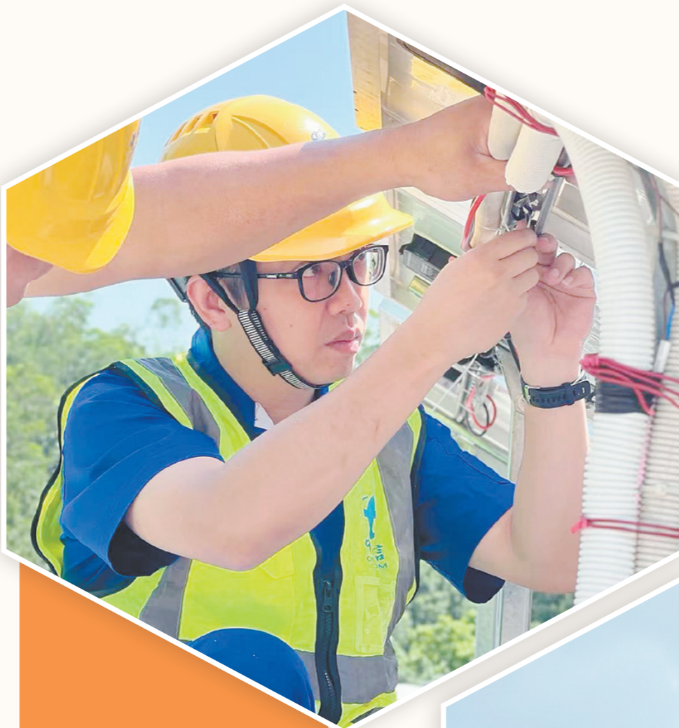
江门电信工作人员对无线通信基站进行太阳能辅助供电系统安装。
