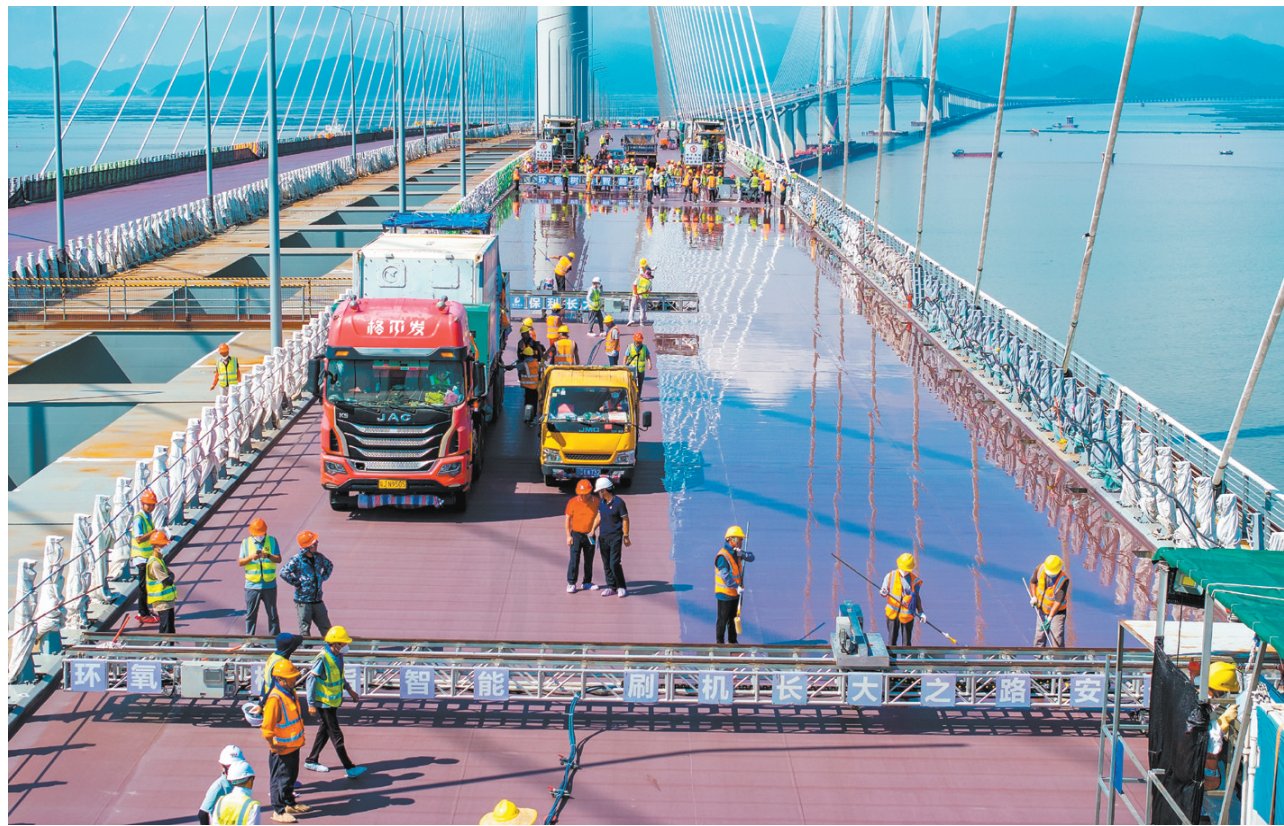
黄茅海跨海通道的建设者们抢抓晴好天气的有利时机进行钢桥面环氧沥青铺装。
