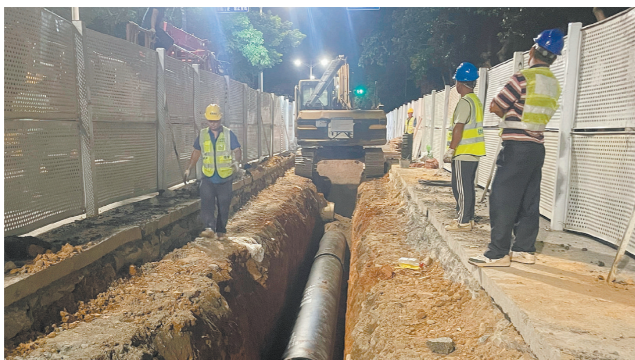
市政人员连夜施工,保证施工进度。
