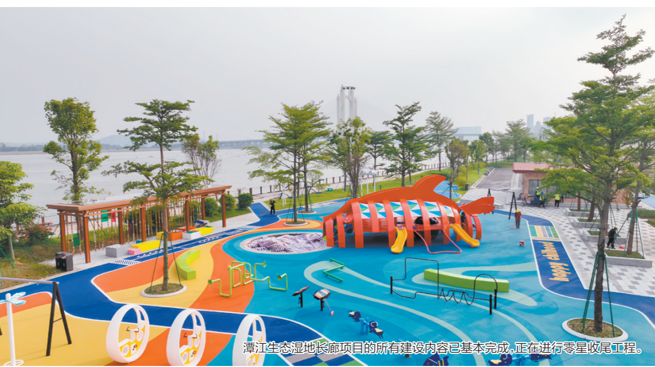
潭江生态湿地长廊项目的所有建设内容已基本完成,正在进行零星收尾工程。
