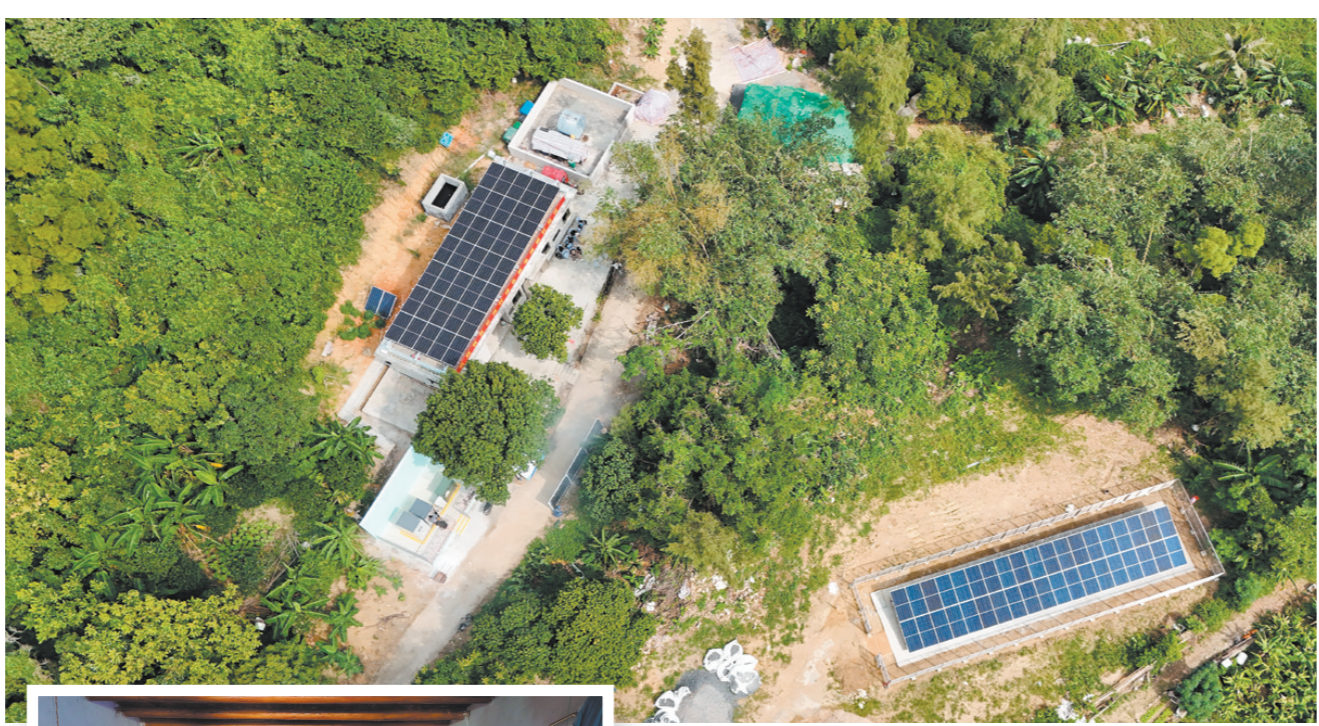
↑茫洲村绿色微电网项目利用洲洲村现有建筑楼顶、草地，建设光伏发电设备，让海岛居民告别“用电难”。
