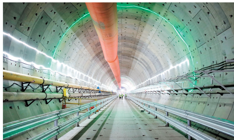
圭峰山隧道盾构段内部。
