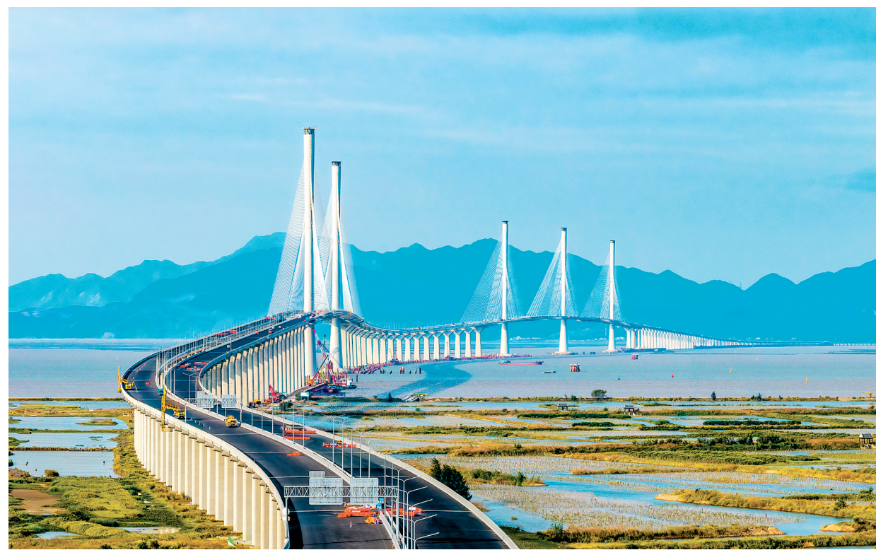
全线完成沥青铺装的黄茅海跨海通道路面实现“白转黑”。
