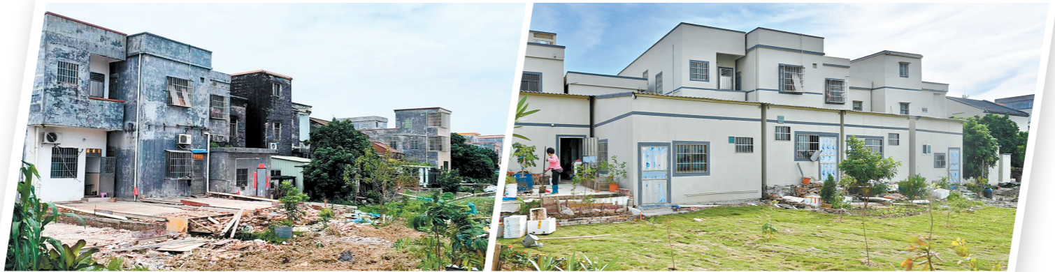
经过改造后，新会区大鳌镇新地村农房风貌品质明显提升。
