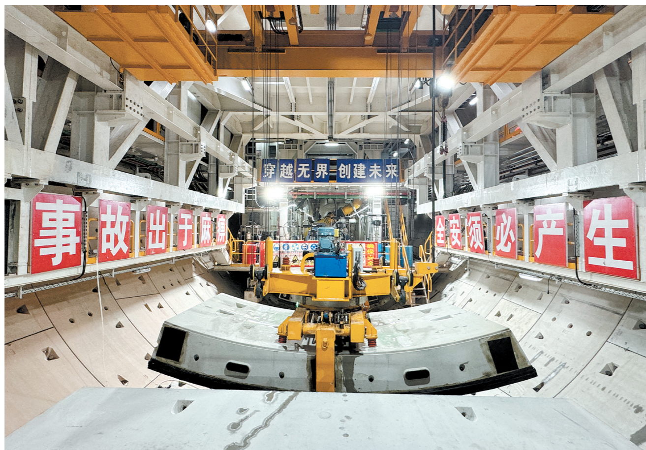
珠肇高铁3标圭峰山1号盾构隧道管片吊装现场。
