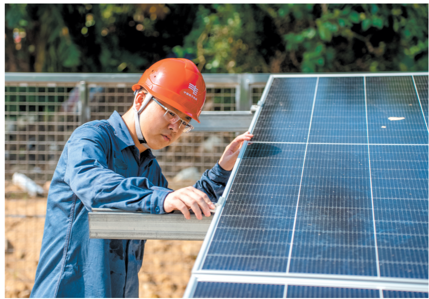
叶林青积极推动洲岛绿色微电网项目建设。
