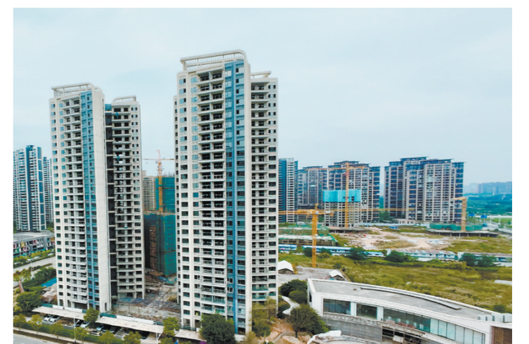
新会佳兆业悦峰府项目部分楼栋已封顶。
