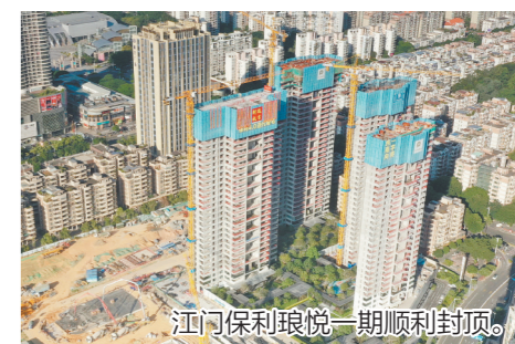
江门保利琅悦一期顺利封顶。
