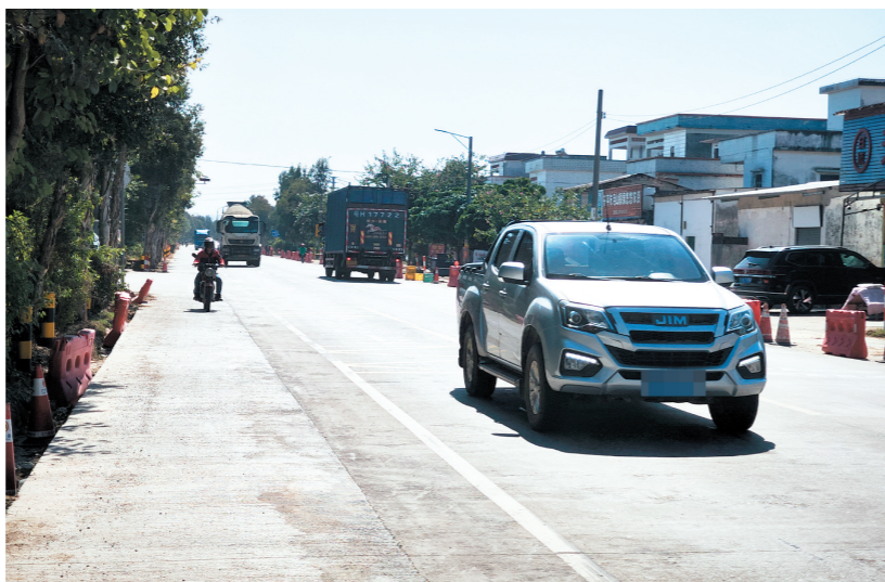
省道S273线月山段两侧路肩升级改造，让群众有更安全舒适的出行条件。
