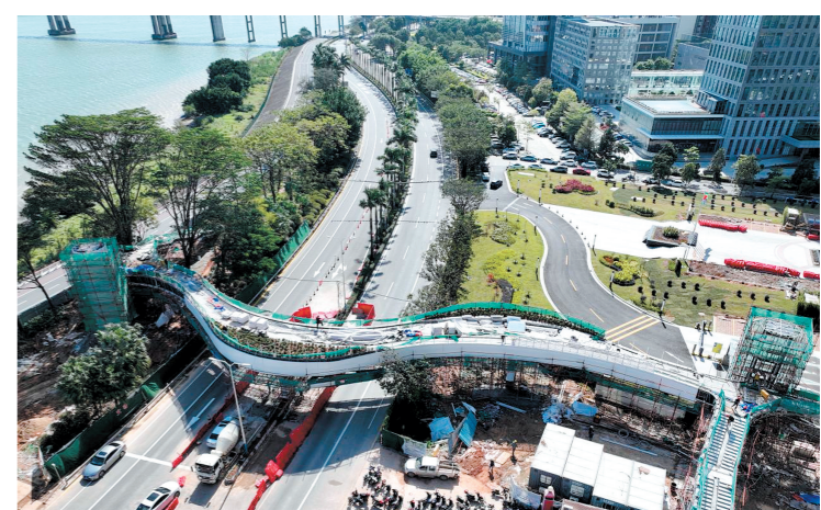
滨江大道首座人行天桥已进入收尾阶段，将于下月建成并投入使用。
