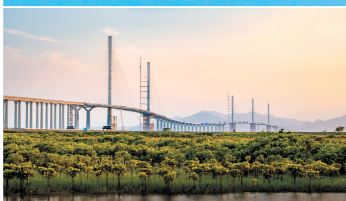
与自然生态融为一体的黄茅海跨海通道。
