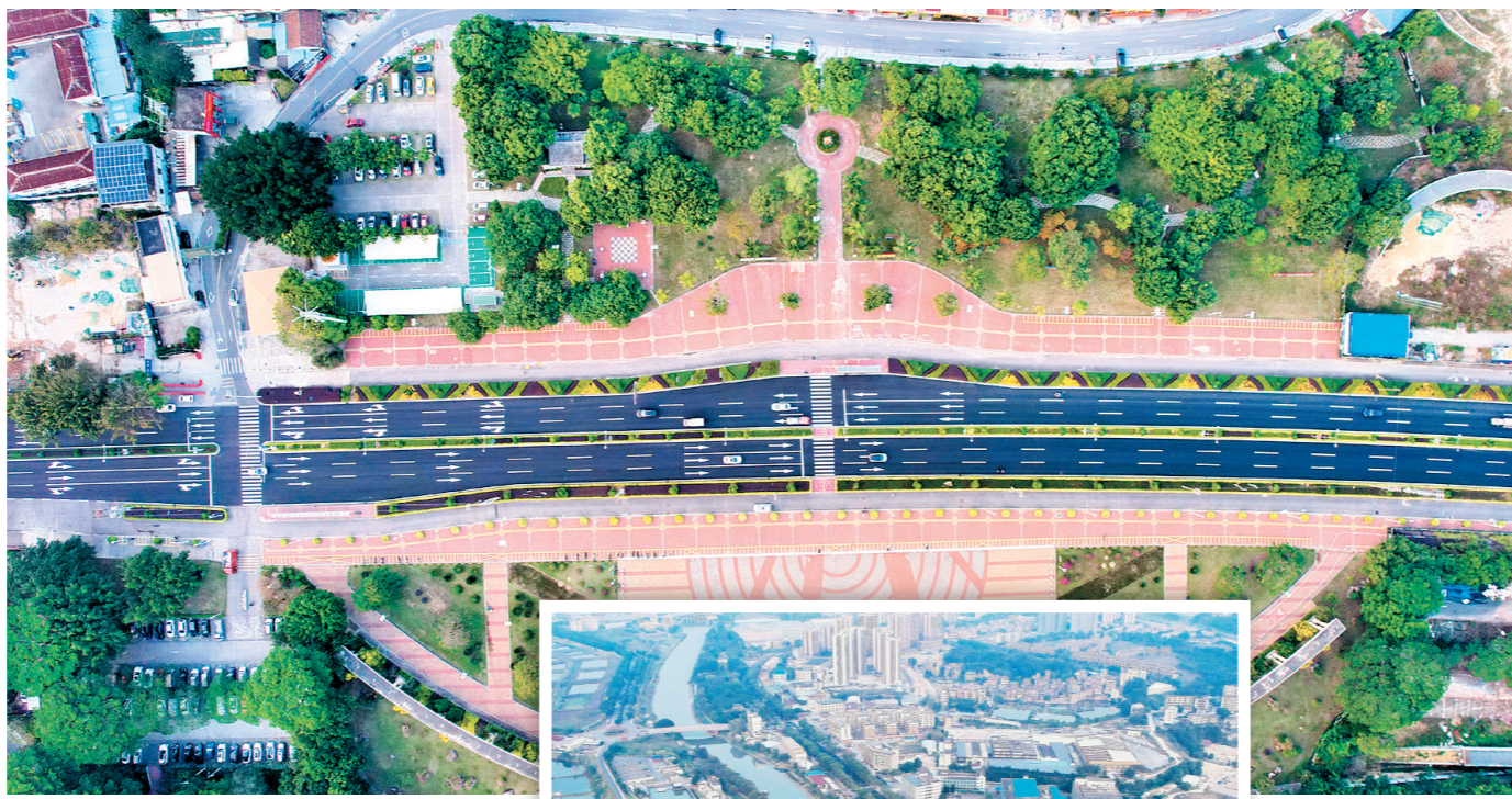
完成省县村道升级67公里,“平安村口”建设7处,“三口一段”整治55处,危桥改造2座,实现四五类危桥全面“清零”。
