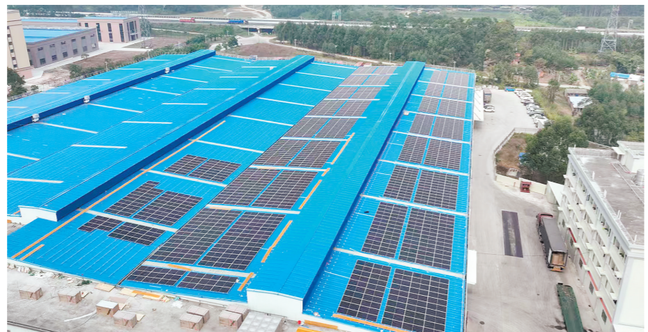
正在施工的恩平沙湖陶瓷城屋顶光伏项目。
