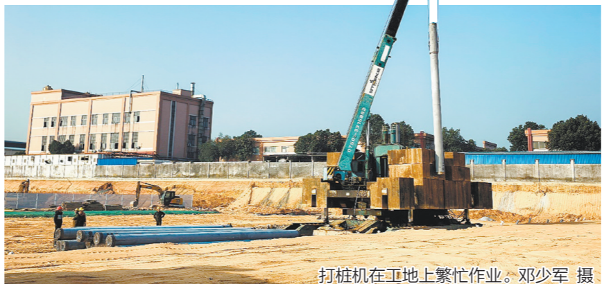
打桩机在工地上繁忙作业。邓少军 摄
