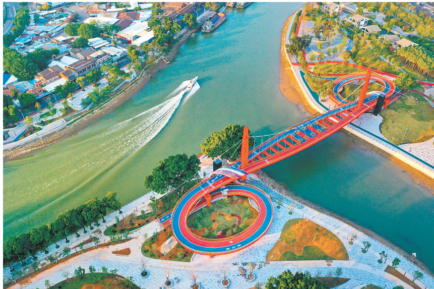
“如意桥”是江门第一座跨江双塔悬索人行天桥。
