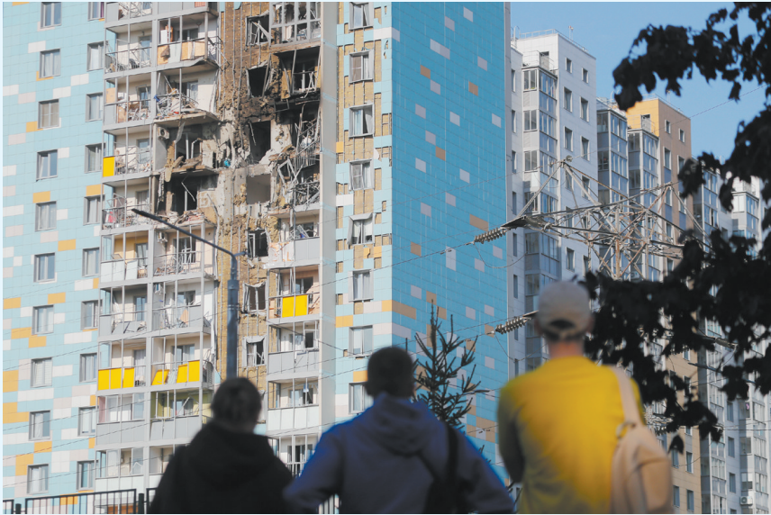
2024年9月10日在俄罗斯莫斯科州拉维斯科耶拍摄的在无人机袭击中受损的建筑。
