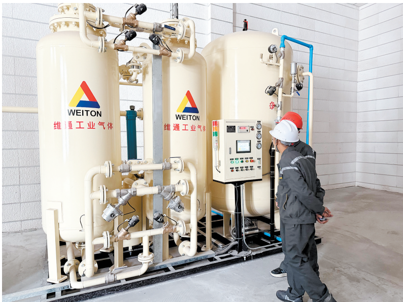
蚬冈粮库工作人员查看粮库充入氮气比例是否正常。
