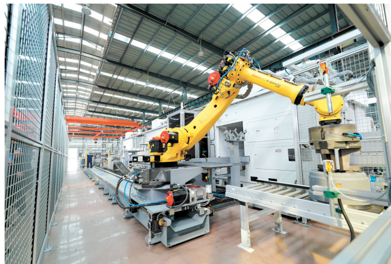
广东富华重工制造有限公司全力推动自动化、数智化制造,大幅提升生产效率。
