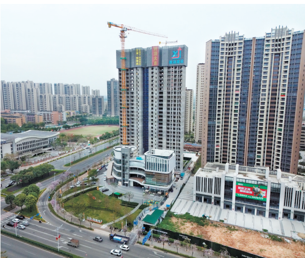
江发·悦璟苑项目1号住宅楼结构顺利封顶。
