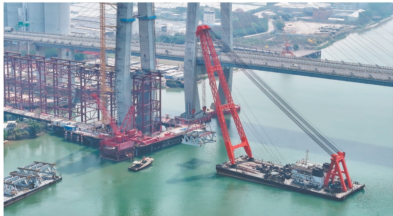
跨磨刀门水道主桥首榀钢桁梁成功架设,深江高铁建设迎来新进展。
