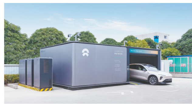
在恩平市大槐镇,蔚来建设了换电站方便车主。
