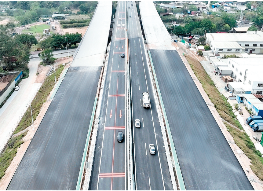
昨日,江鹤高速公路改扩建项目龙湾互通至莲花山互通路段全封闭交通管制措施正式解除,车辆畅行。
