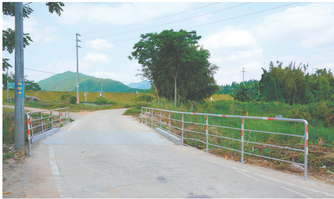
大泽镇第二水库桥改造完工,为村民安全出行提供有力保障。
