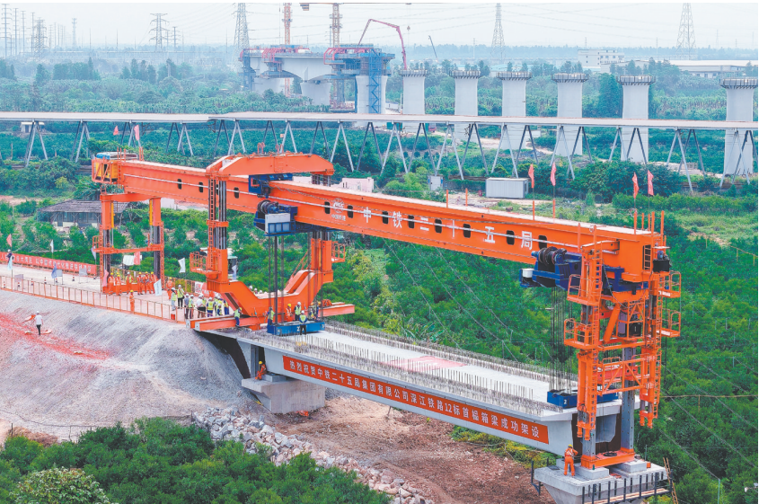
4月30日拍摄的深江铁路江门段首根预制箱梁架设现场（无人机照片）。新华社发
