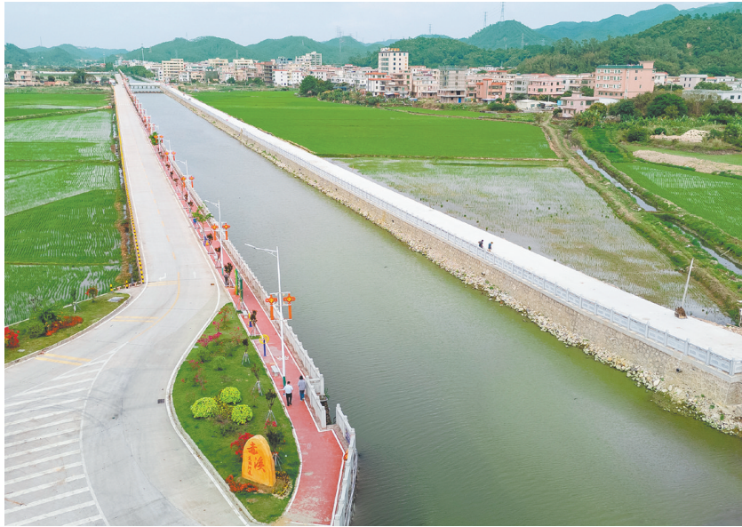
赤溪镇的美丽河道白霄河,连续贯通3公里,河岸建有1.4公里的慢行步道。
