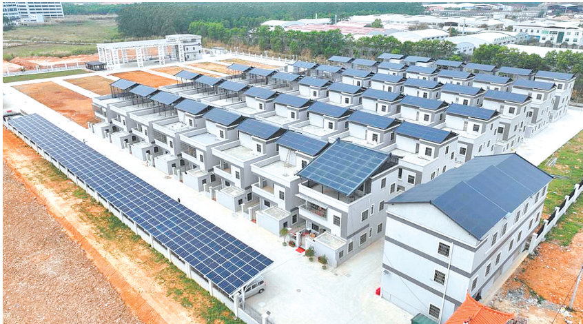
鹤山加快推进“光伏+建筑”应用试点工作。图为址山镇莲珠新村农村屋顶分布式光伏项目。
