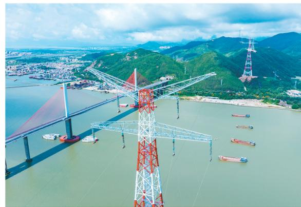
施工团队在水面关键位置布置了4艘千吨级重型搁线船,为整个牵引过程提供了强大的稳定支撑和安全保障。
