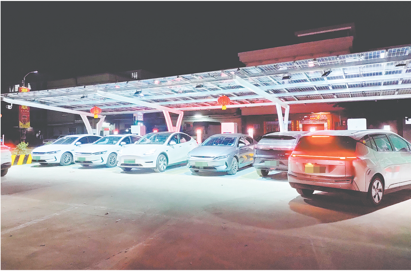
君堂侨联充电站项目填补了君堂镇新能源充电桩的镇域空白。
