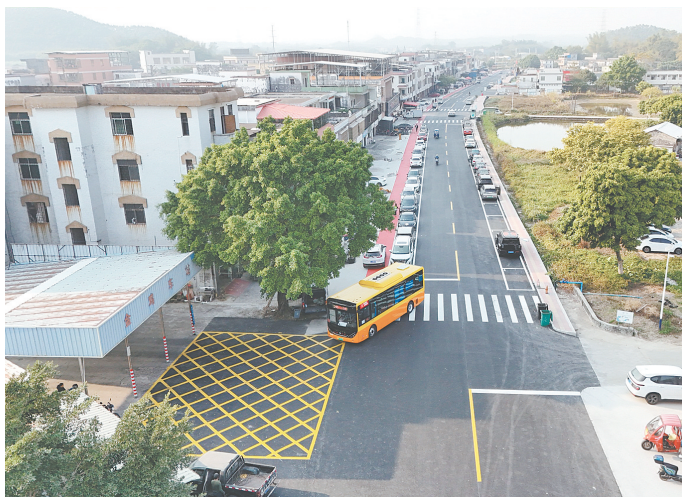
金鸡镇开展银龙路升级改造工程，基础设施不断提档升级。 金鸡镇政府供图
