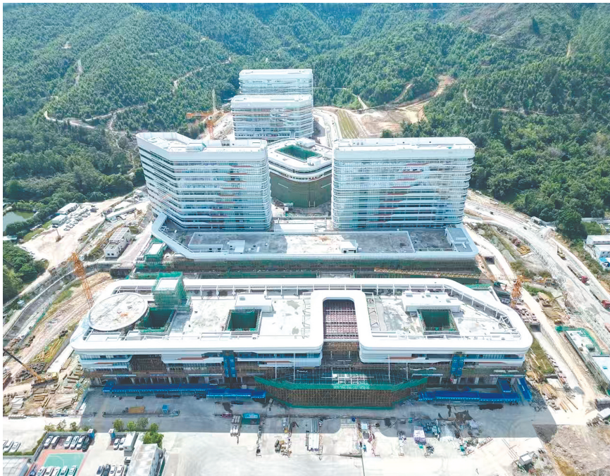
江门市新三甲医院建设项目主体结构与外立面装修已完成。
